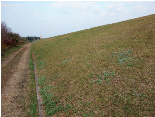
写真 51 冬が近づいた河川敷法面
