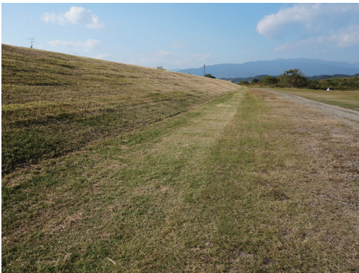
写真 45 再び除草され綺麗になった法面
